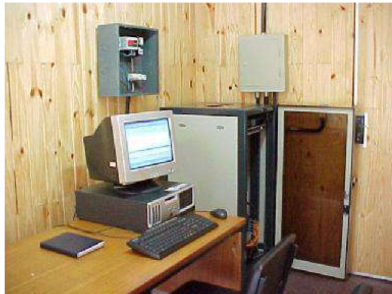
Figura 5.4. Estação de medição.
