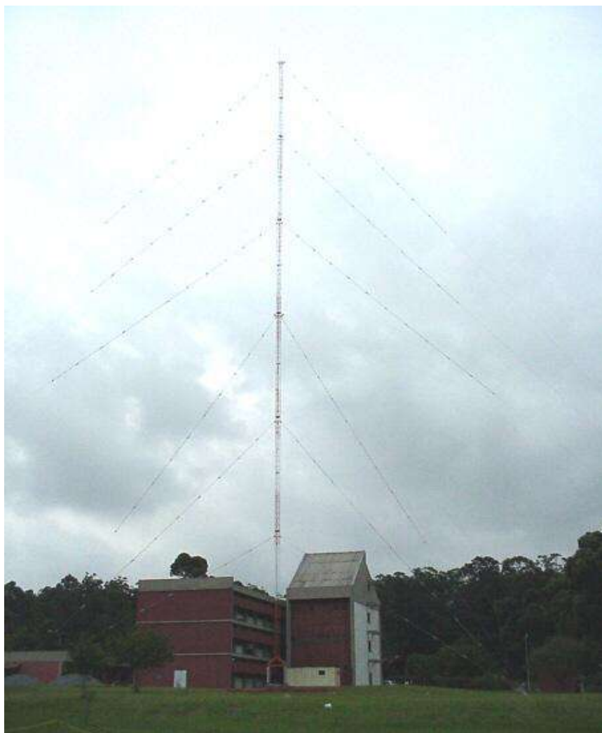
Figura 5.2. Mastro para captação de descargas.
